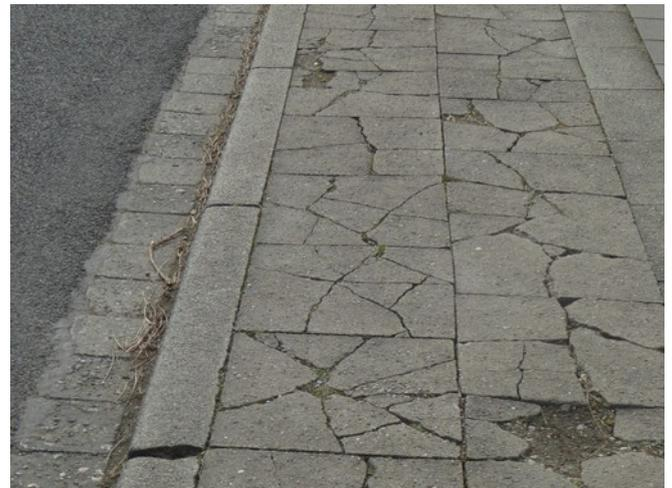
Bild 11: Typische Gehwegschäden durch zu schwere Fahrzeuge
